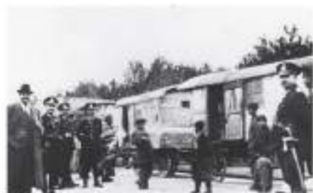
Gitanos menores obligados a ir a "campes de habitación" instalados de los campos de exterminio.
